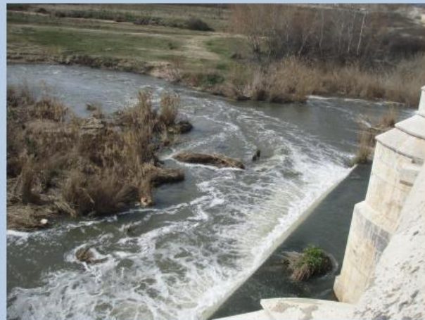
Puente Largo del Jarama convertido en colector de depuración.
